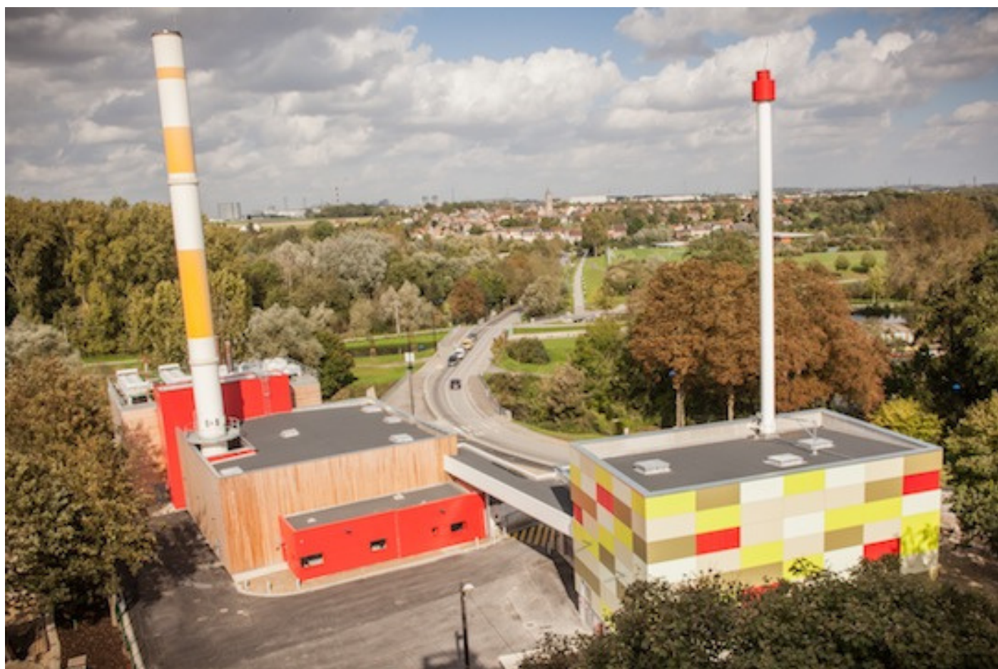
Chaufferie d'Etouvie à Amiens
